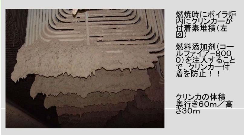
燃焼時にボイラ炉内にクリンカーが付着素堆積(左図)
