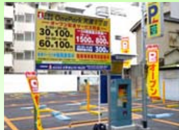
駐車場設備の設置工事
