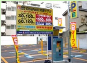
駐車場設備の設置工事
