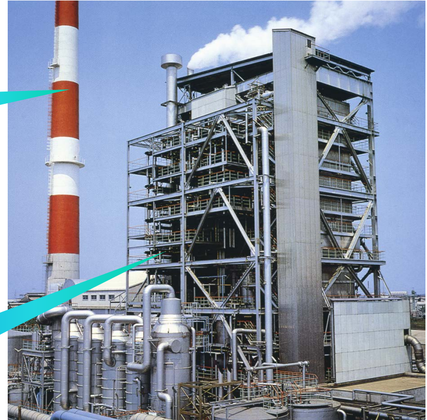
火力発電所のボイラー全景
