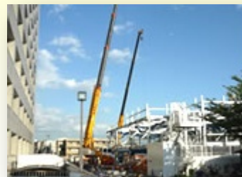
駐車場設備の設置工事
