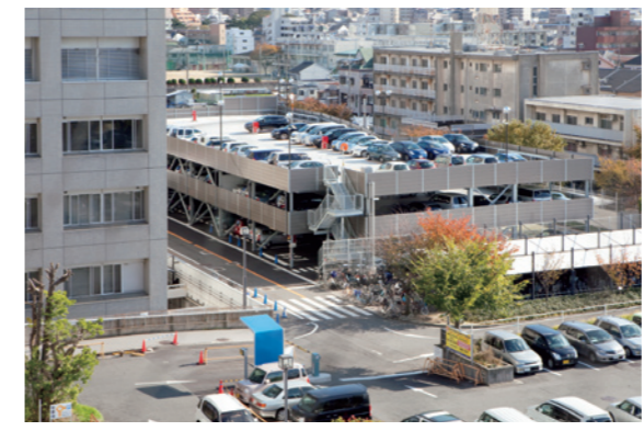
立体駐車場の導入事例（大阪府立急性期・総合医療センター）
