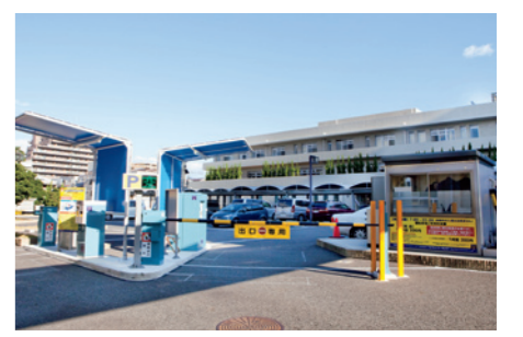
平面駐車場の導入事例（大阪府立急性期・総合医療センター）
