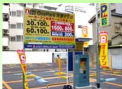
駐車場設備の設置工事
