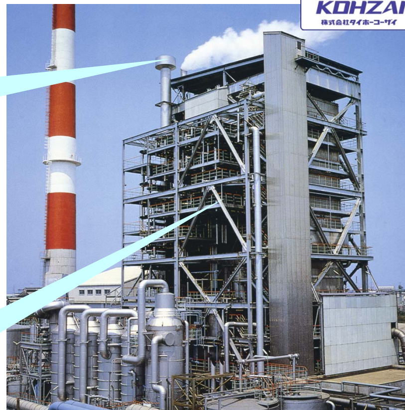
火力発電所のボイラー全景
