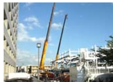
駐車場設備の設置工事
