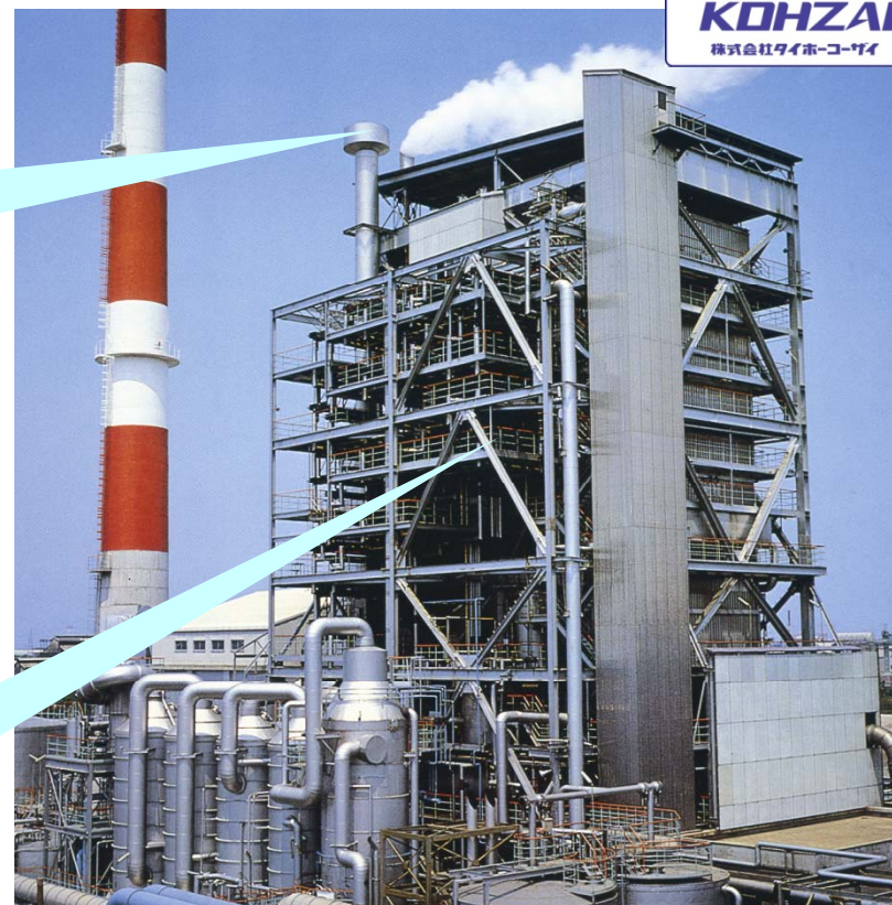
火力発電所のボイラー全景
