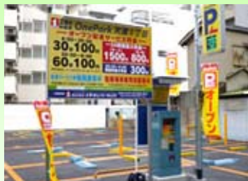
駐車場設備の設置工事
