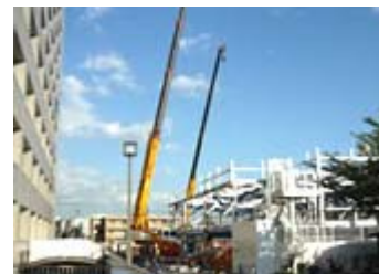
駐車場設備の設置工事
