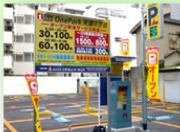
駐車場設備の設置工事
