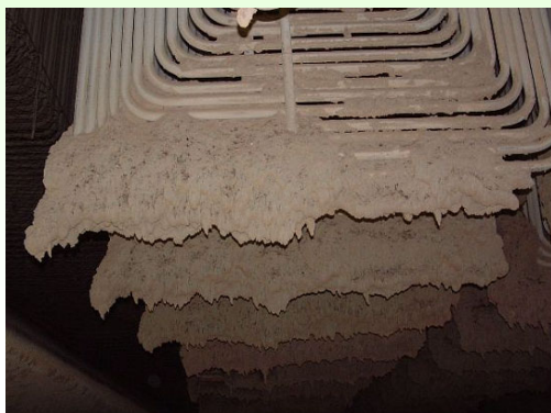
燃焼時にボイラー炉内にクリンカーが付着し堆積した状態。(奥行き60m/高さ30m) 燃料添加剤(コールファイア-8000)を注入することで、クリンカー付着を防止！！
