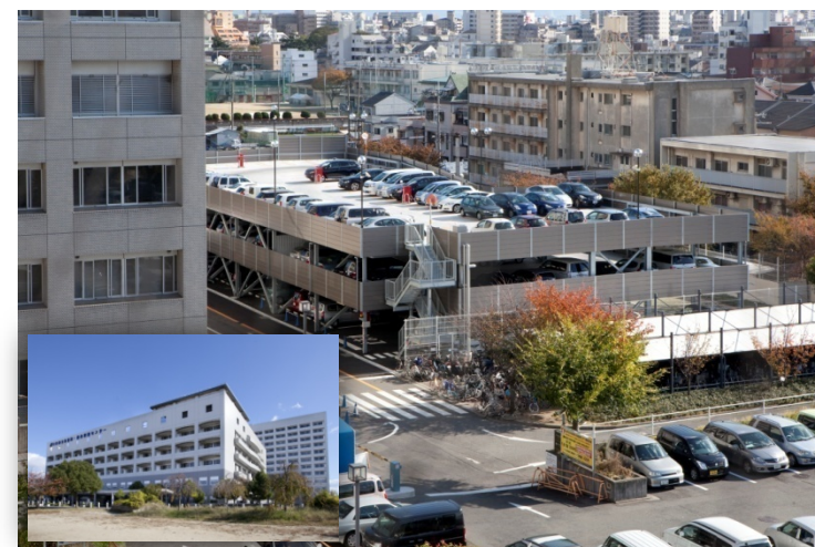
大阪府立急性期・総合医療センター（旧大阪府立病院）様の事例写真
