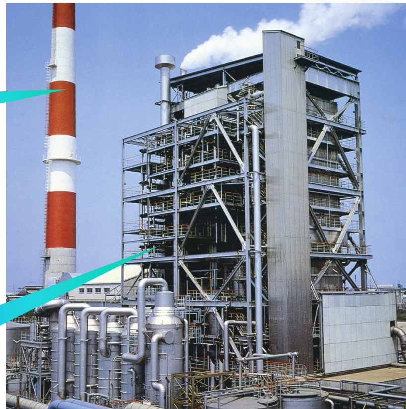
火力発電所のボイラー全景
