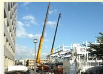
駐車場設備の設置工事
