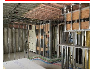
通電前の屋内作業に
