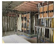
通電前の屋内作業に
